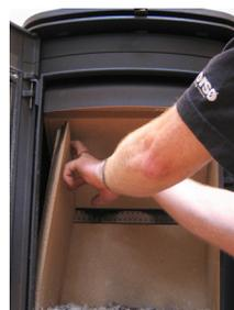
2. Inclinez une brique latérale et retirez-la de la chambre de combustion.
