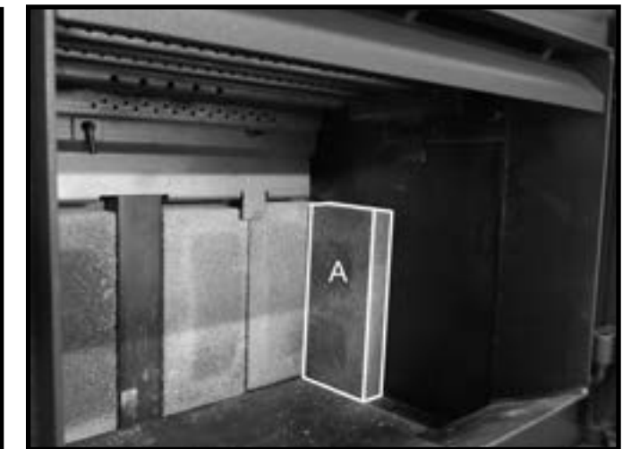
Figure 11: Première brique posées sur le mur droit.
