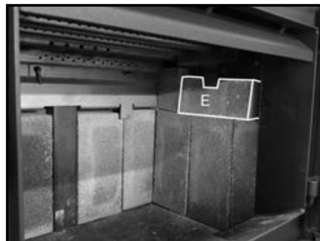
Figure 14: Dernière brique posée sur le mur droit.
