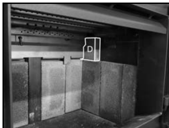
Figure 13: Petite brique posée dans la partie supérieure du mur droit.
