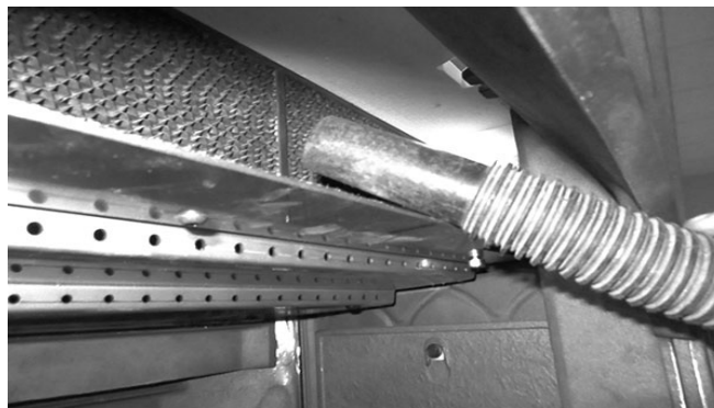
Figure 18. Passez l'aspirateur sur les cellules de la chambre de combustion après le brossage.
