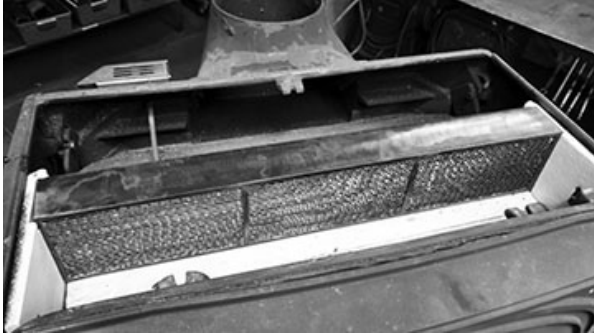
Figure 23. Soulevez la chambre de combustion de la chambre.
